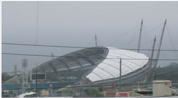
写真-1 韓国済州島の西帰浦サッカースタジアム
