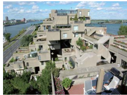
モントリオールのハビタ 67。有名な集合住宅なのでご存知の方も多いかもしれませんが、その所有のしかたも組合所有というユニークなものになっています。日本の区分マンションとは、増改築のルールや管理の方法が大きく異なります。
