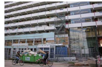
集合住宅の再生 (アムステルダム)。画一的な団地から多様性に富むまちへの再編が進められています。
