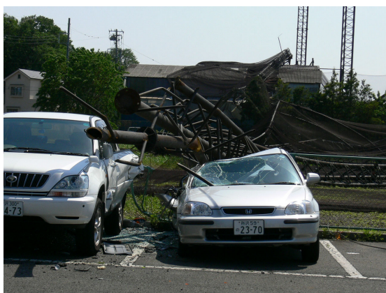
倒壊した鉄塔による自動車の被害
