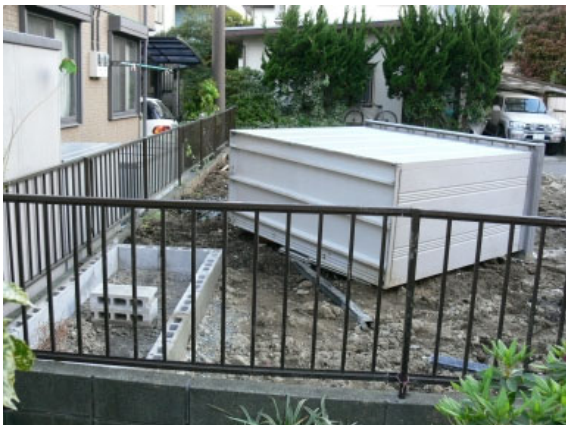
簡易物置の転倒（南西方向へ転倒）
