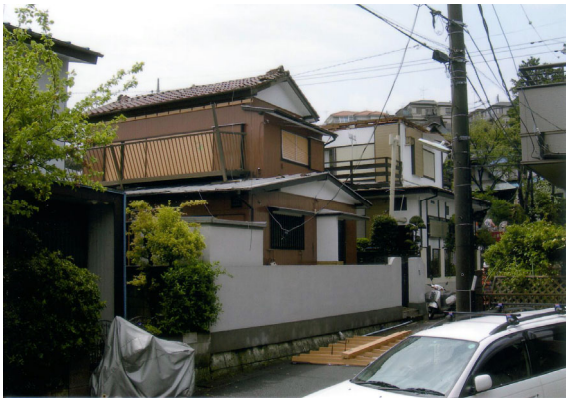
東側ベランダ庇の損傷（手前）北東方向へ飛散した。
