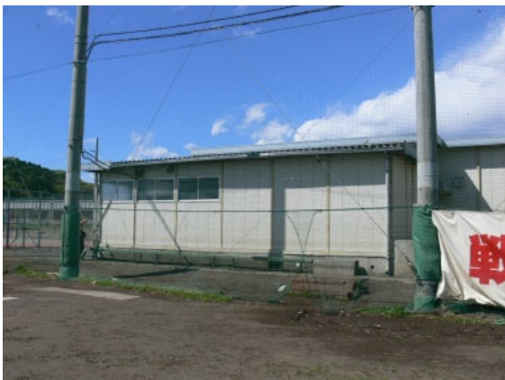
運動場倉庫の庇の損傷と北北東へ 100m 程度飛散した葺材
