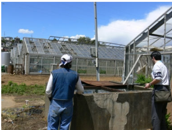
温室(ガラス張り)の被害, 手前の鉄製の井戸の蓋が飛散した。
