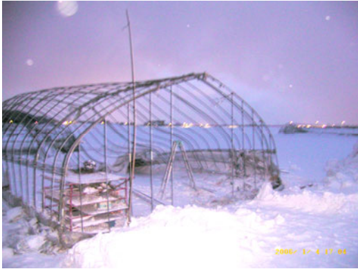
地点4 石名坂地区におけるビニルハウスの被害
