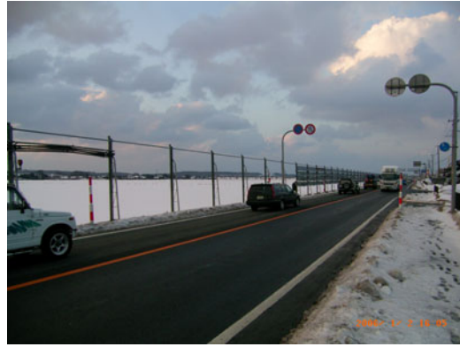
地点2 広栄町における防雪柵の被害
