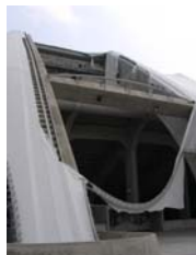
Fig. 1 Membrane broken
