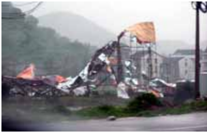
広告牌が倒れた
